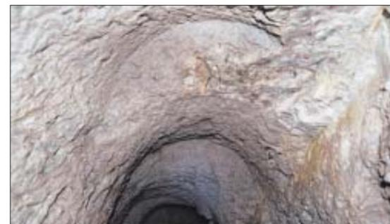
Hier sieht man die bogenartigen Bearbeitungsspuren an der Stollen-Firste. Nur mit Schlägel und Eisen wurde dieses Profil erstellt.
